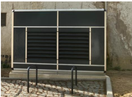
Wärmepumpe
