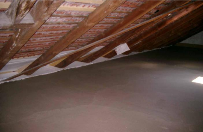
PS-Dämmung mit Estrich
