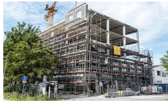
Bürogebäude Frankfurter Ring, München
