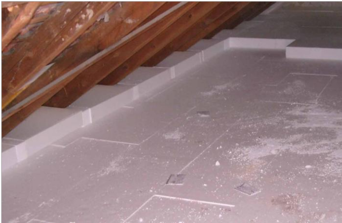
PS-Dämmung U-Wert 0,12 W/(m 2 K)
