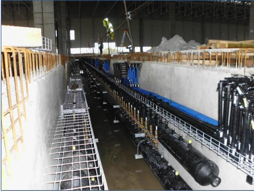
Verteiler mit Anschlüssen der Energiepfähle
