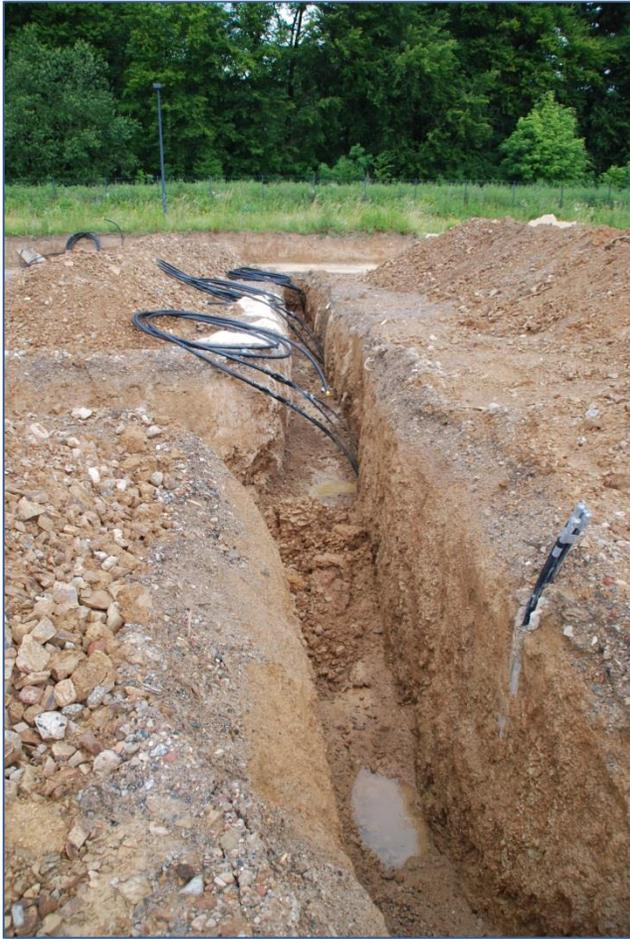
Graben mit Anschlussrohren der Sonden
