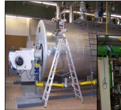
Wärmeerzeugung über 2 Erdgas-Heißwasserkessel
