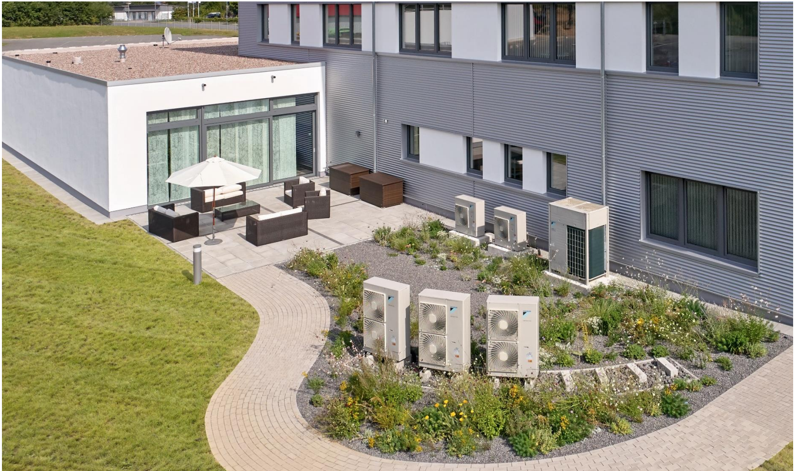
Monovalente Gebäudebeheizung mit Luft-Wasser-Wärmepumpen
