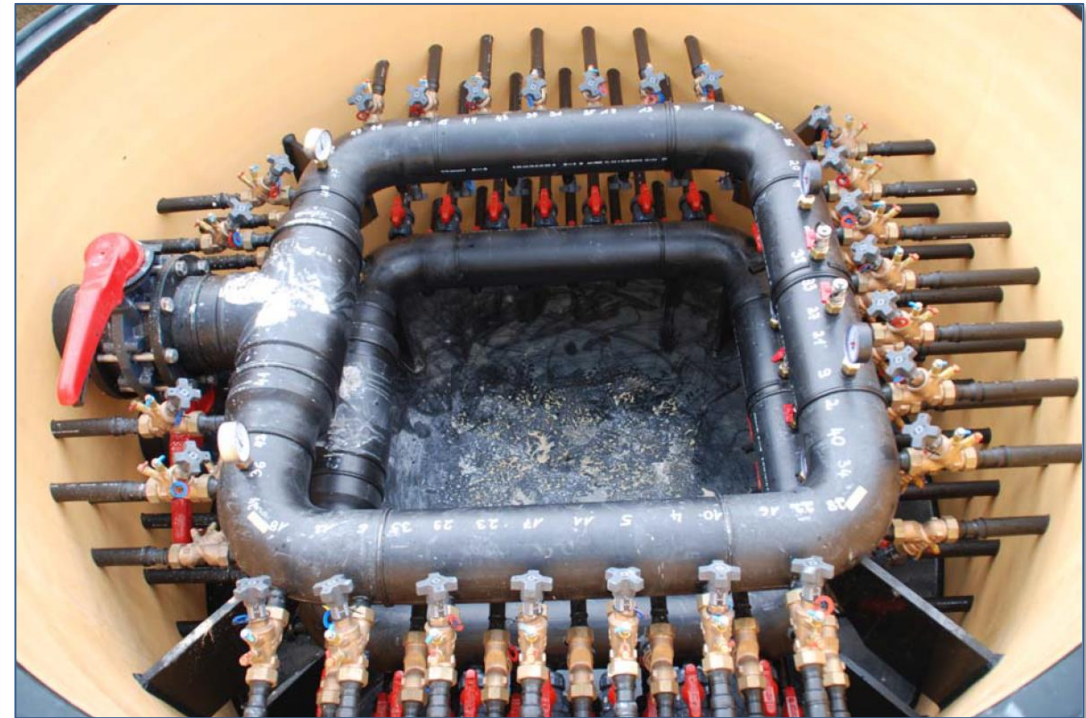
Verteiler des Geothermiefeldes mit 50 Sonden
