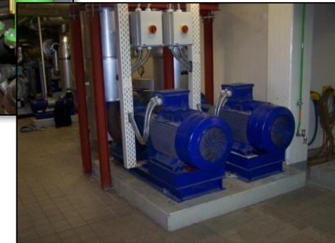
Pumpen in der Kälteverteilung
