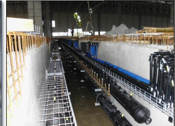
Verteiler mit Anschlüssen der Energiepfähle
