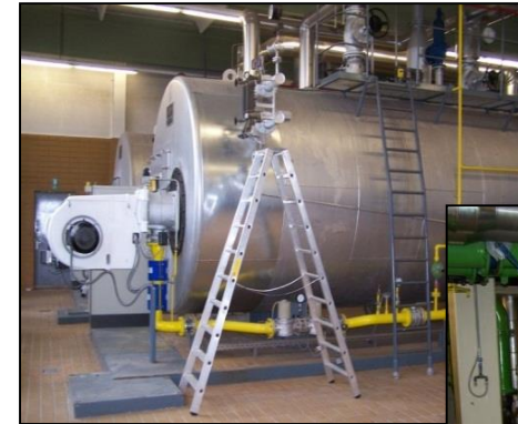
Wärmeerzeugung über 2 Erdgas-Heißwasserkessel
