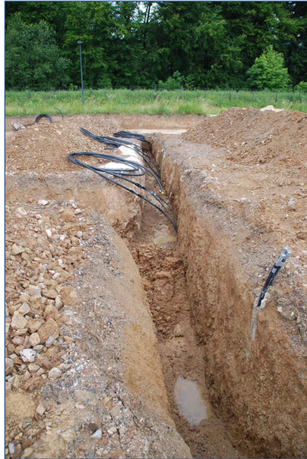
Graben mit Anschlussrohren der Sonden
