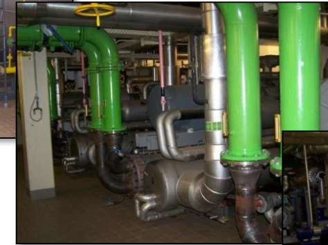
Kälteerzeugung 6/12°C über 6 Hubkolben-KKM
